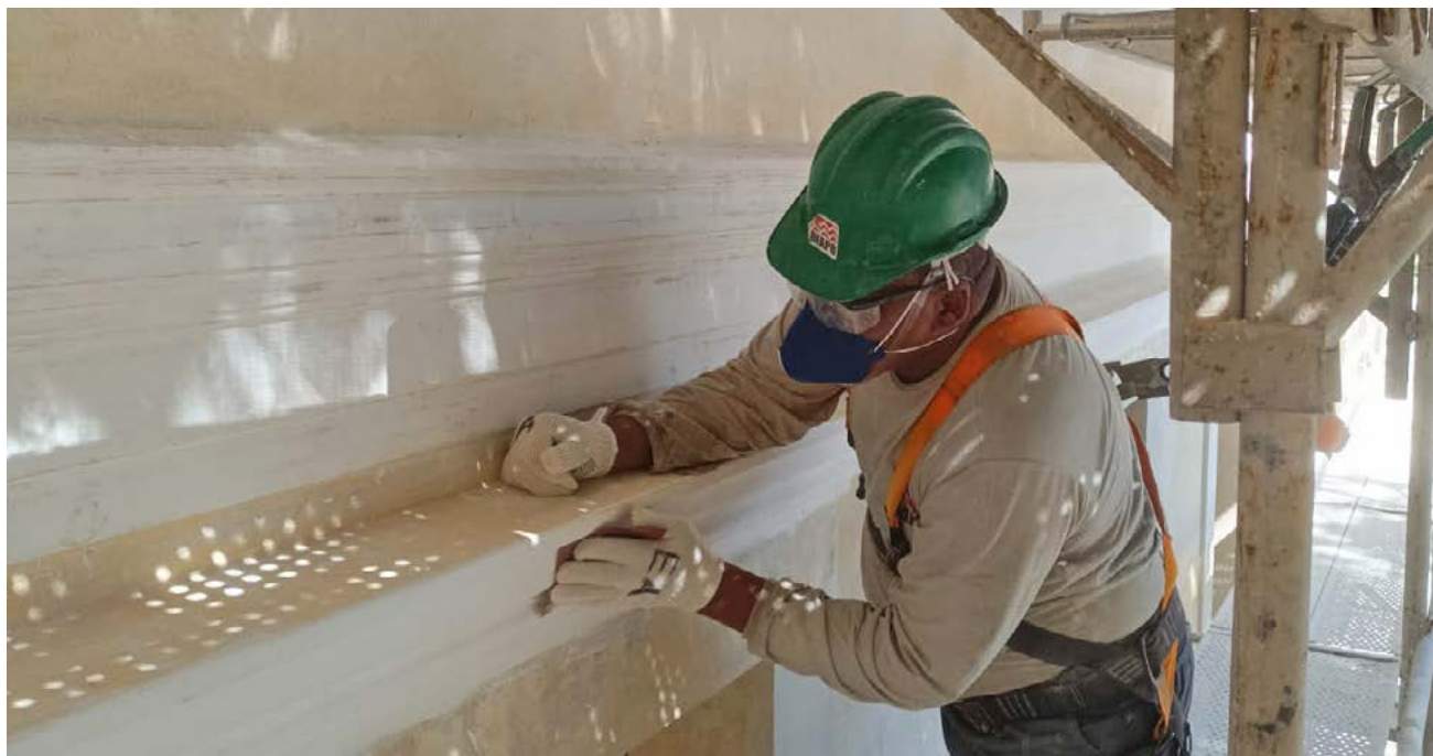
A recuperação das fachadas e das coberturas de três blocos está concluída
