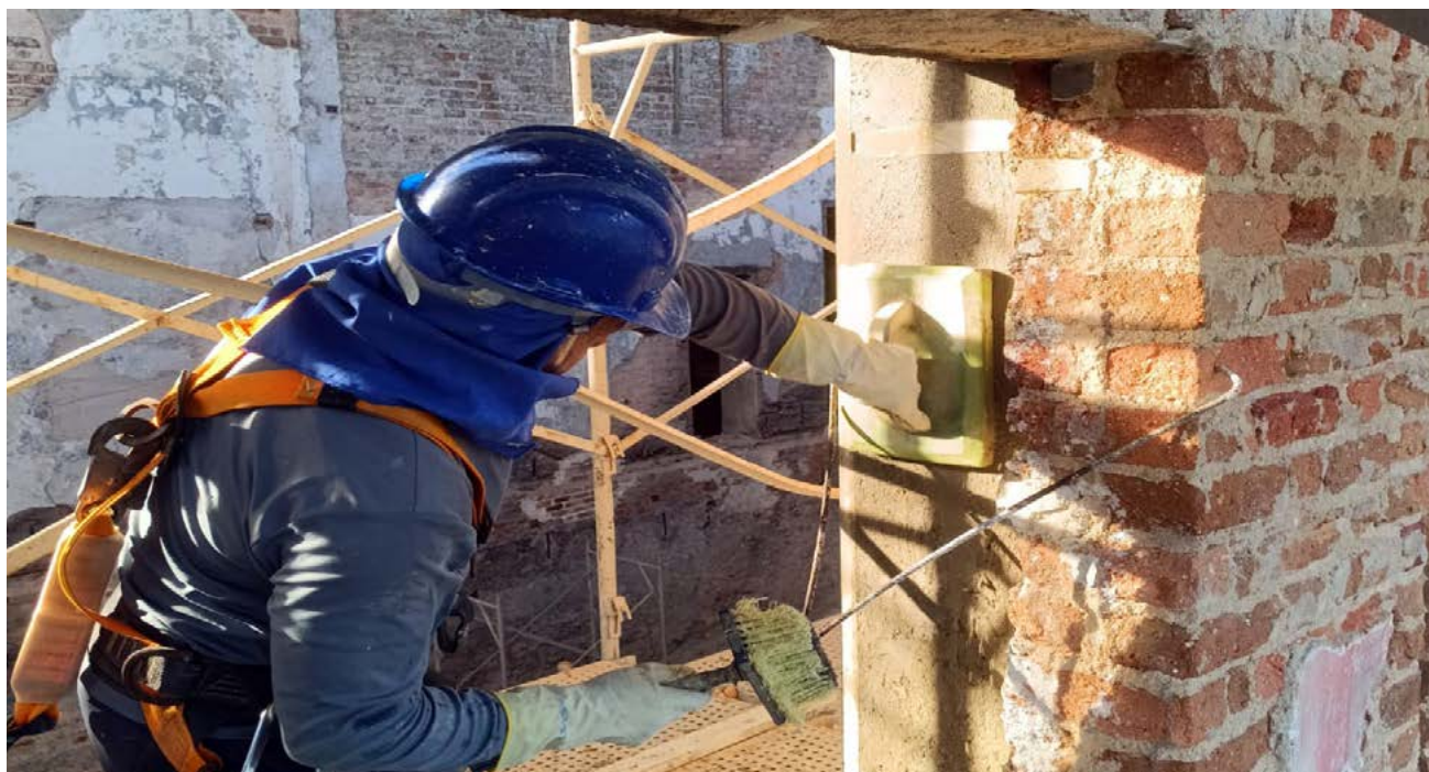
Foco atual está na regeneração de alvenarias e no reforço estrutural
