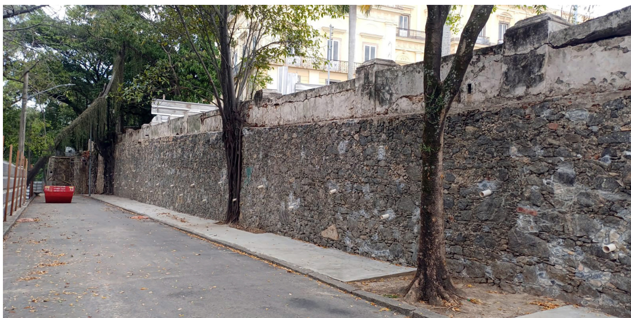
Muros do entorno da edificação receberam intervenções preventivas e de manutenção
