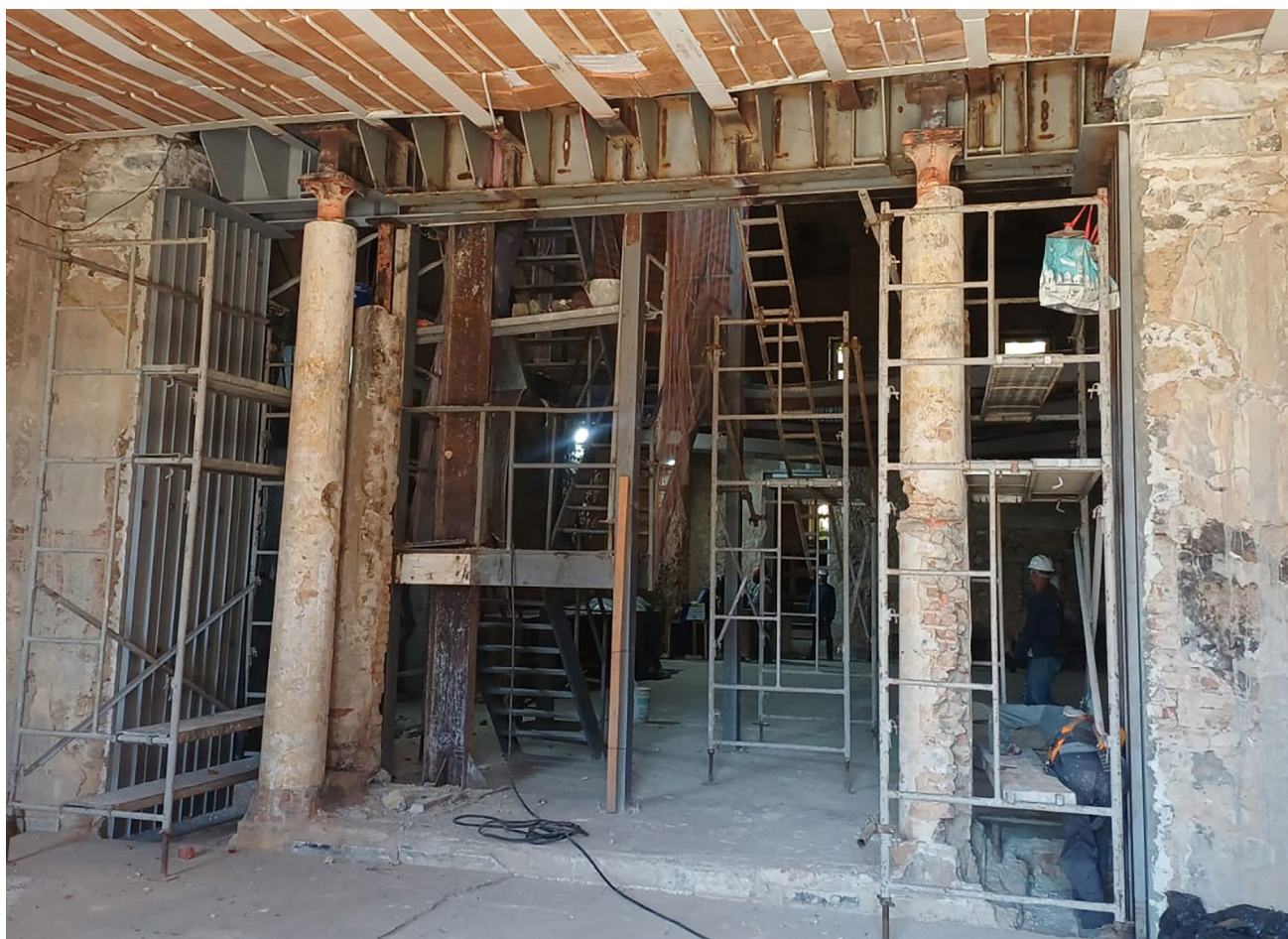
Sala das Vigas expõe o processo de reconstrução da estrutura de sustentação do edifício
