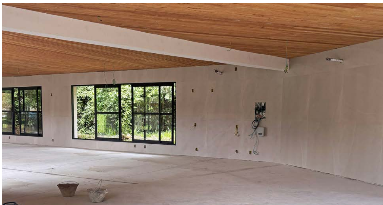
O novo centro turístico e cultural do Rio de Janeiro está com 80% das obras concluídas
