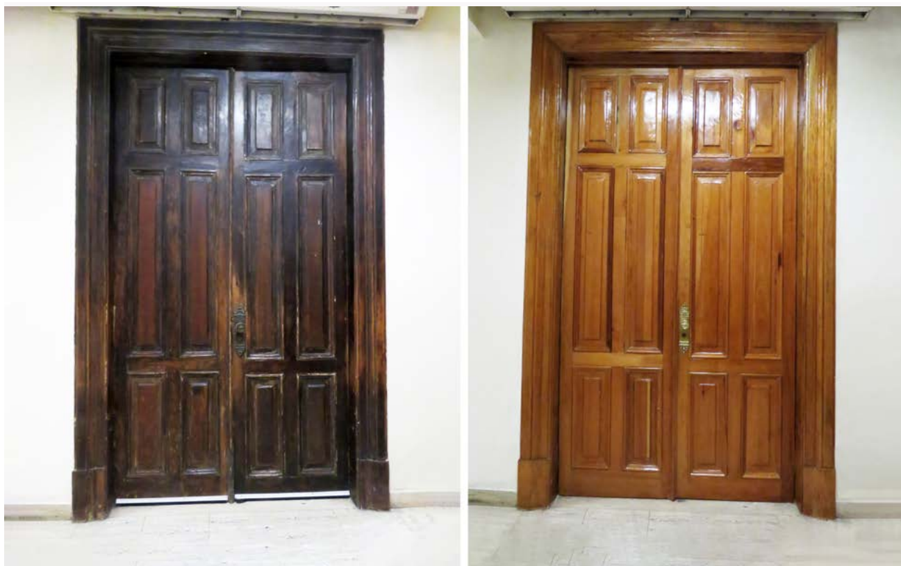
Restauração de portas incônicas parte da valorização dos materiais e suas características originais
