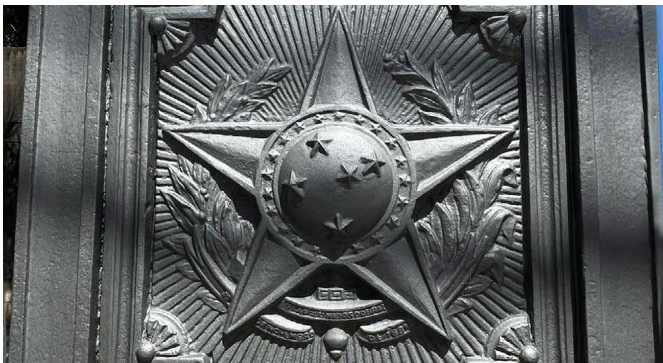
Fachadas imponentes, gradis e elementos de ferro fundido refletem a sofisticação construtiva da época
