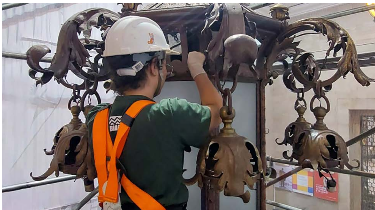
O restauro das luminárias integra as ações de conservação do edifício histórico
