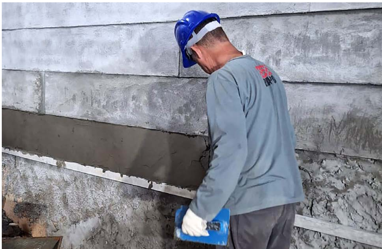
Recomposição das paredes em argamassa polimétrica simulando o ripado do concreto
