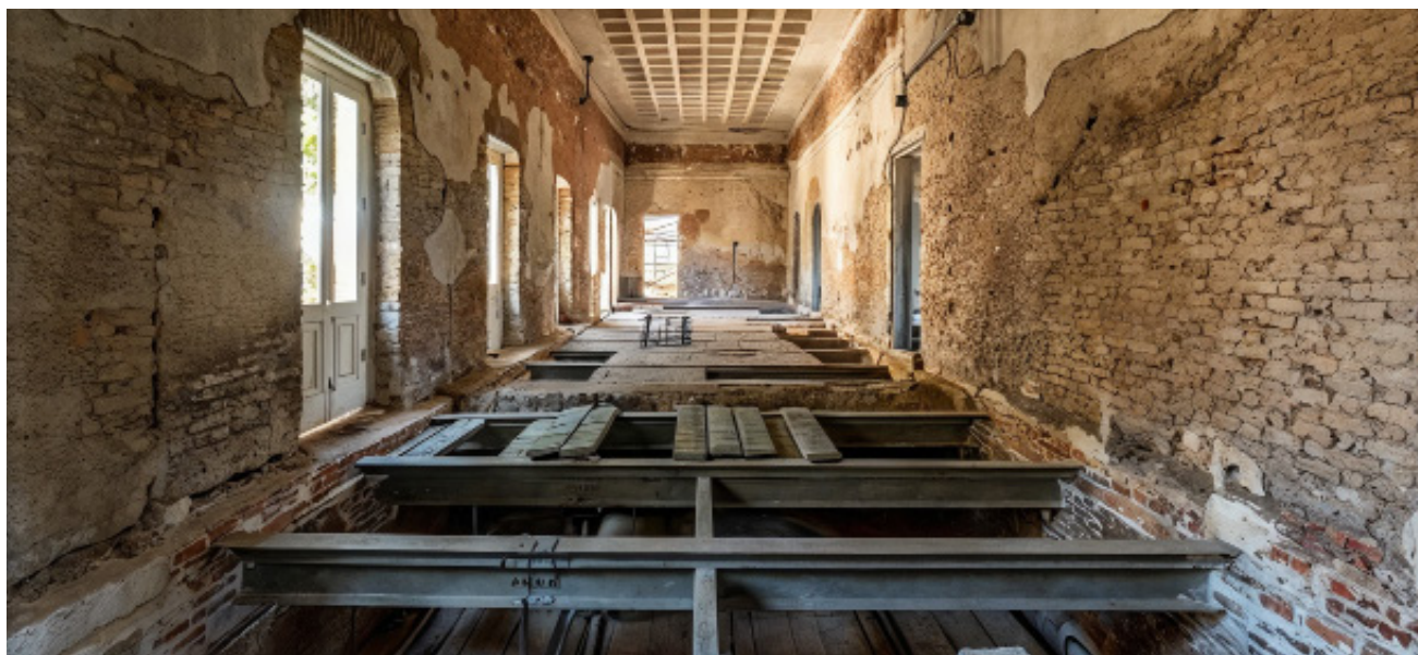
Execução de laje mista combina estrutura metálica e concreto armado. Créditos: Marcos Reis
