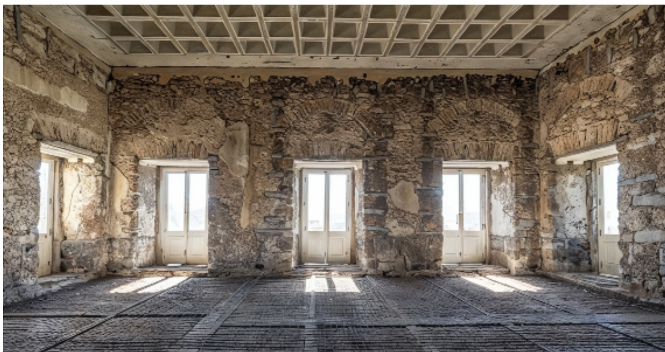
Laje mista pronta para concretagem. Créditos: Marcos Reis
