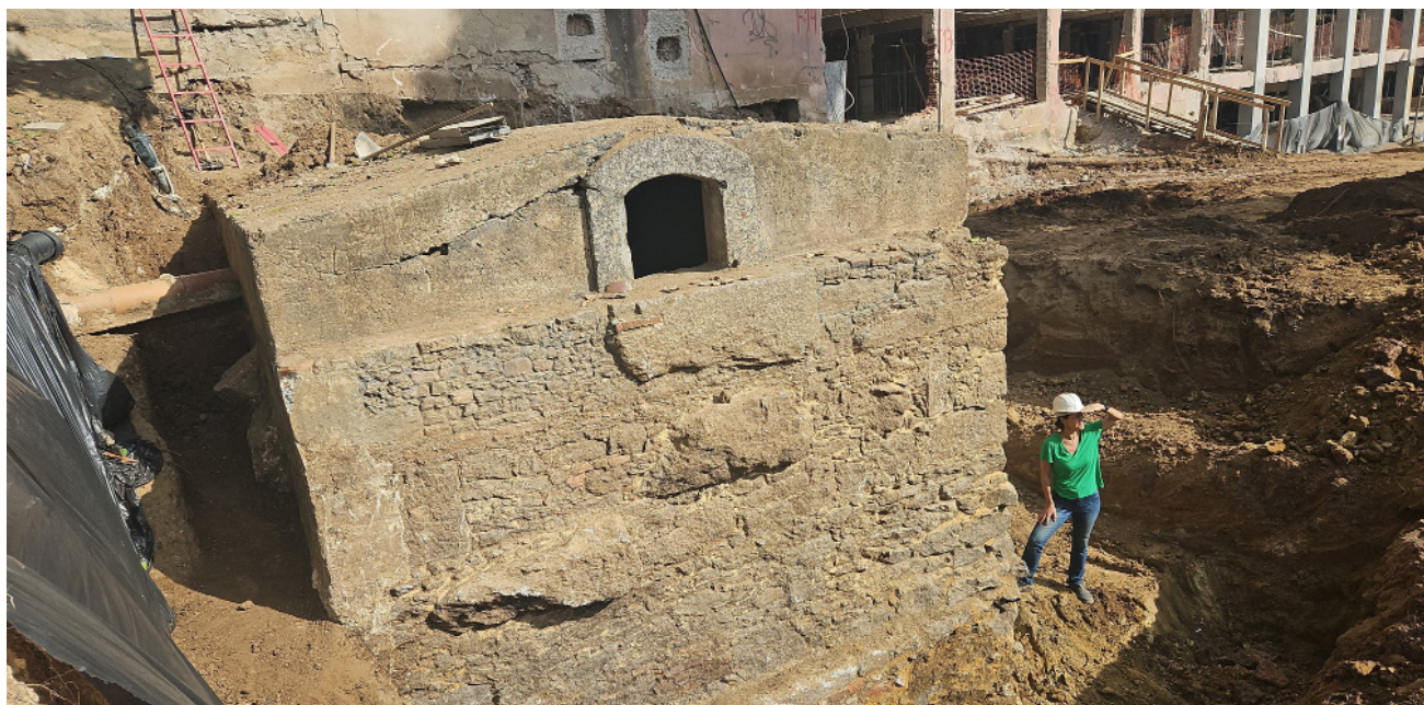
Escavações da cisterna ocorreram entre maio e junho
