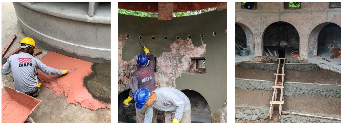
*Acabamento das alvenarias e execução do selo de argila para prevenir infiltrações no solo-cimento*
