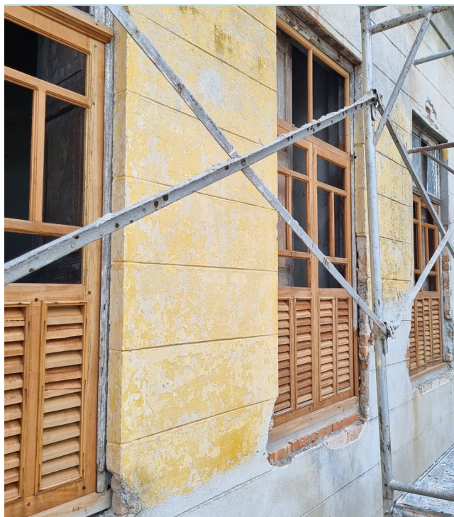
Remoção e substituição de esquadrias de madeira na fachada lateral direita.
