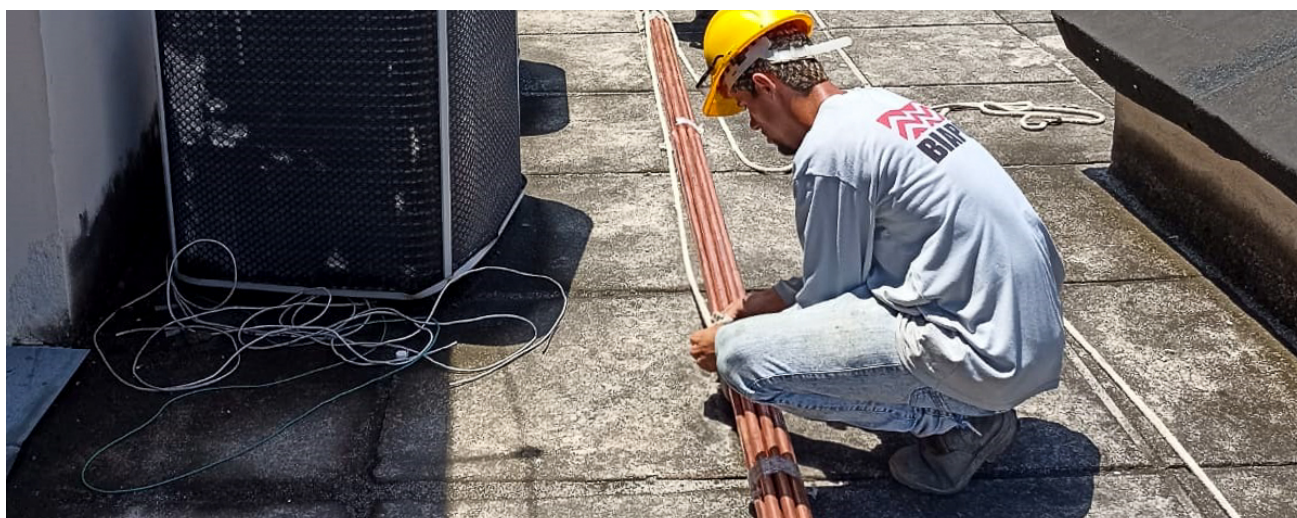
Instalações embutidas estão sendo refeitas em paredes, lajes e pisos
