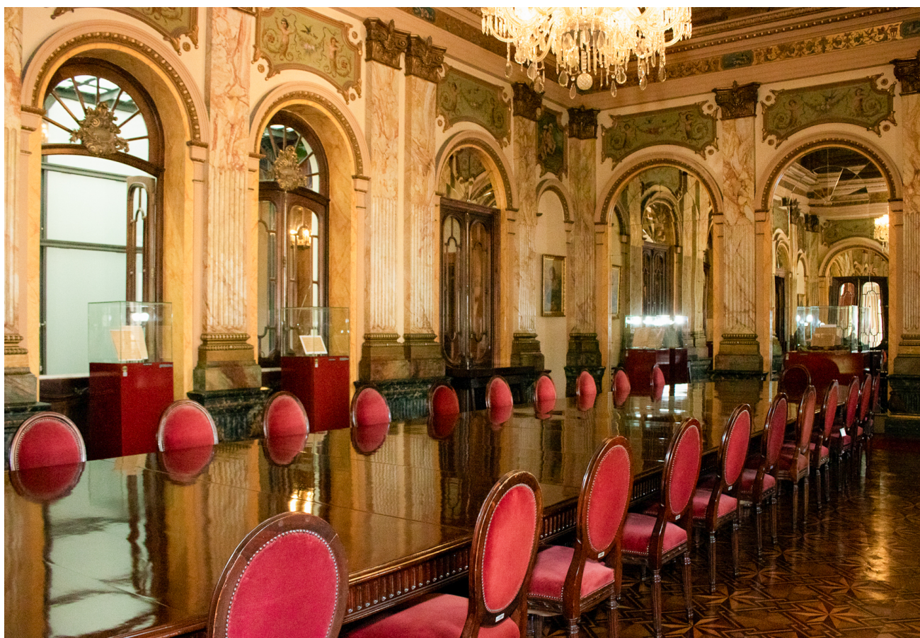
Salão de banquetes possui pilastras com pinturas que simulam mármore
