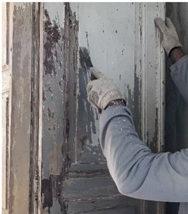
Decapagem e fabricação das esquadrias conforme o projeto original
