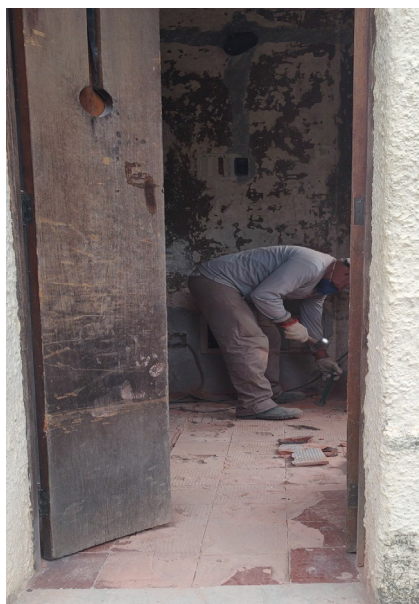
Avança a escavação de vala no interior da torre para reaterro com solo-cimento
