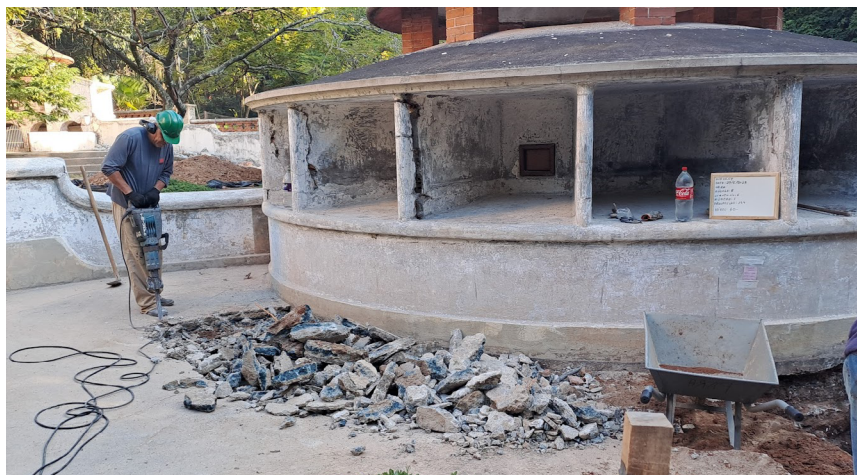
Demolição de piso e serviços de estabilização das estruturas estão em andamento
