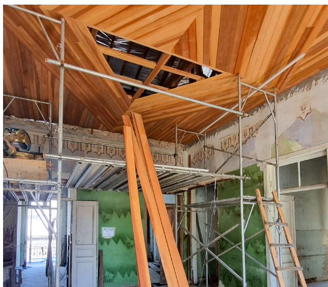
Recolocação de forro é executada em madeira cedrinho
