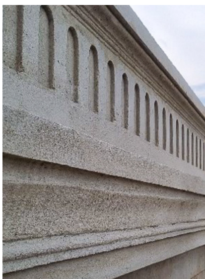
A platibanda foi executada em argamassa, e a cimalha, em concreto armado, chumbada com vergalhões
