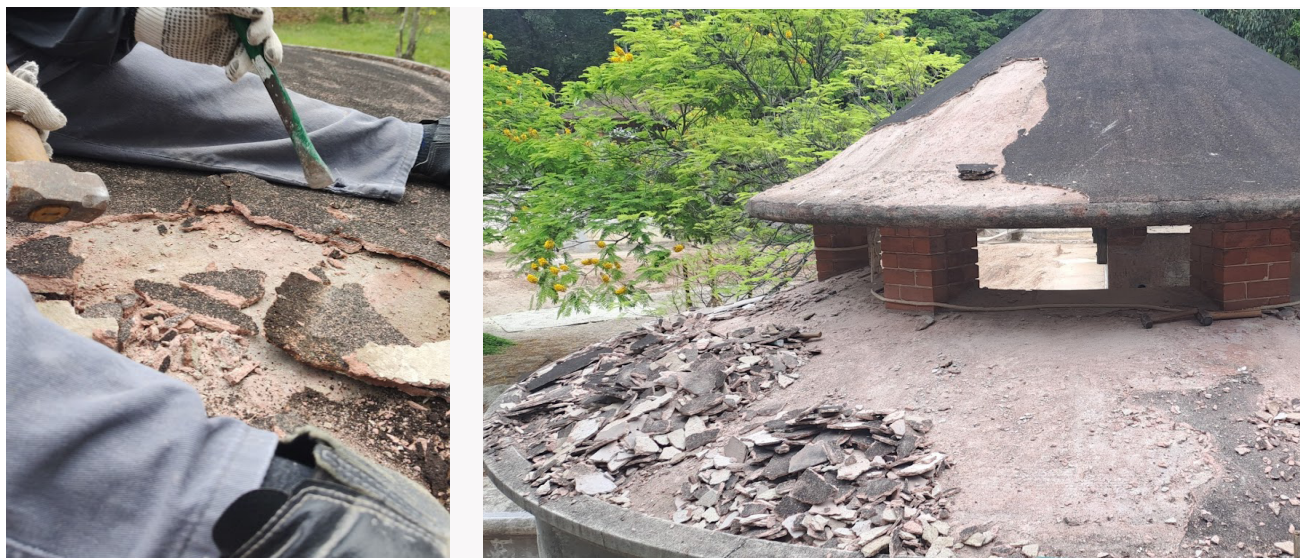
Remoção de camadas de intervenções é feita nas coberturas dos módulos
