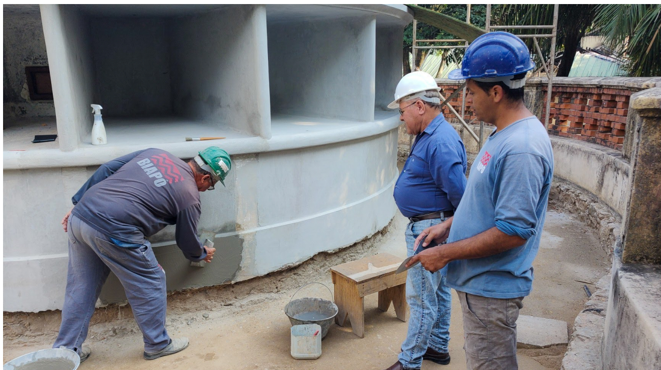
Teste de traço de argamassa com acompanhamento do mestre João Batista nas alvenarias dos módulos
