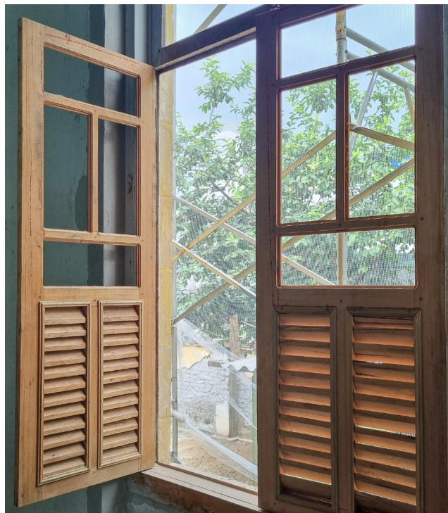
Remoção e substituição de esquadrias de madeira na fachada lateral direita.
