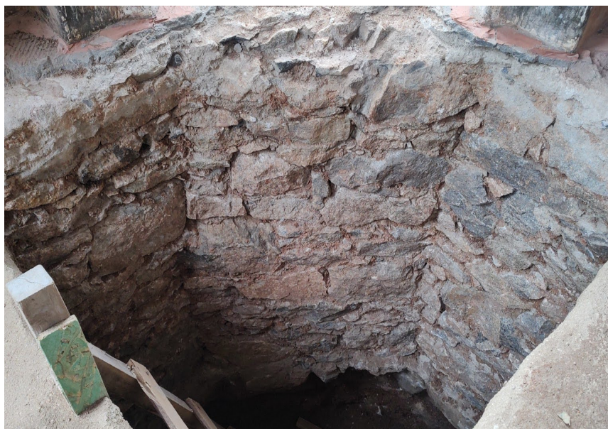
Avança a escavação de vala no interior da torre para reaterro com solo-cimento
