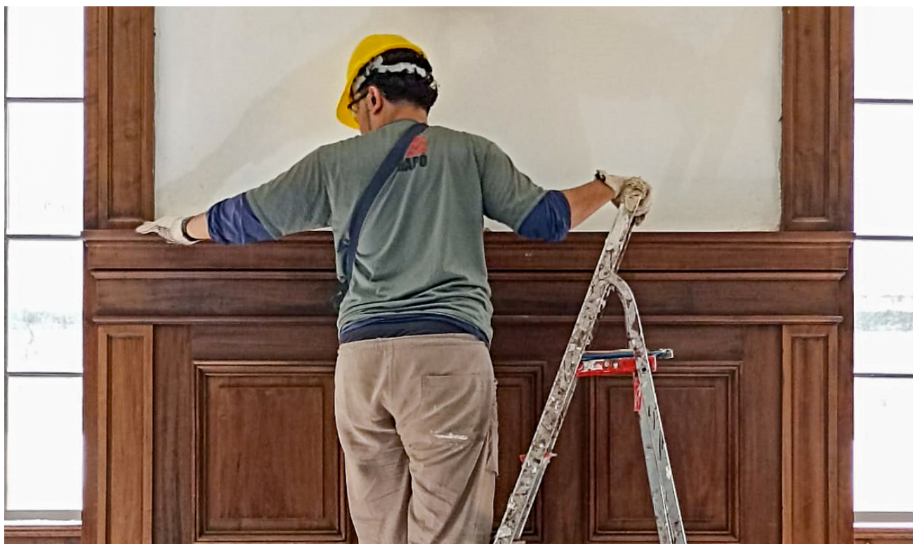
Esquadrias em madeira são restauradas com técnicas que alinham rigor e arte
