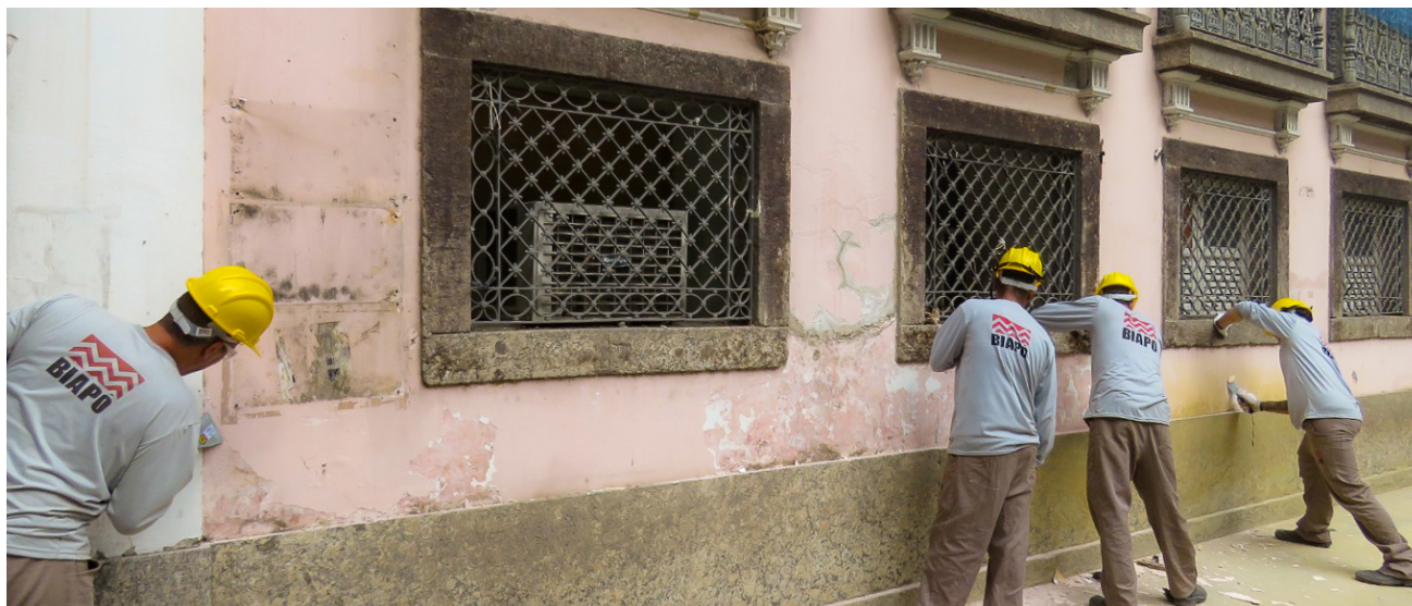
O prédio possui porão alto e acesso lateral, características do final do século XIX
