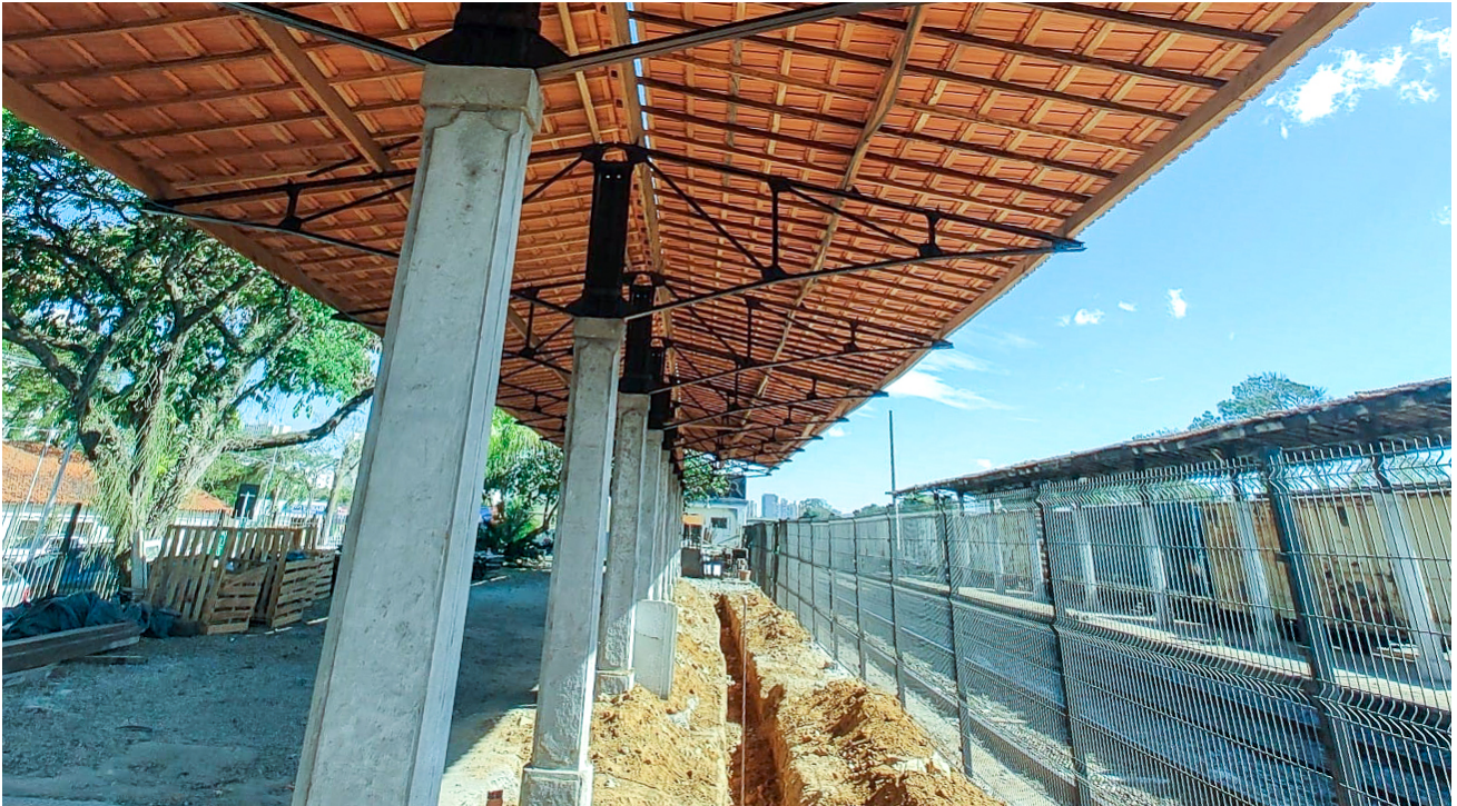
Recortes e ajustes no madeiramento são feitos antes da instalação
