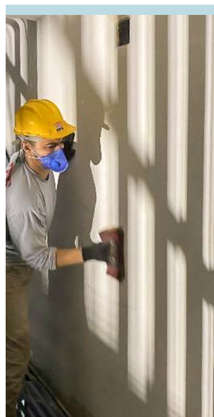
Foram executados serviços de decapagem do teto, remoção de verniz e lixamento de paredes
