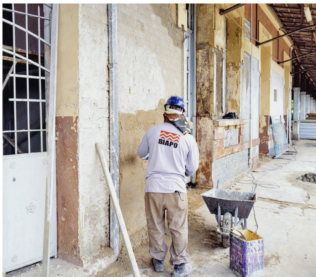
Elementos de destaque na composição arquitetônica recebem aplicação de argamassa
