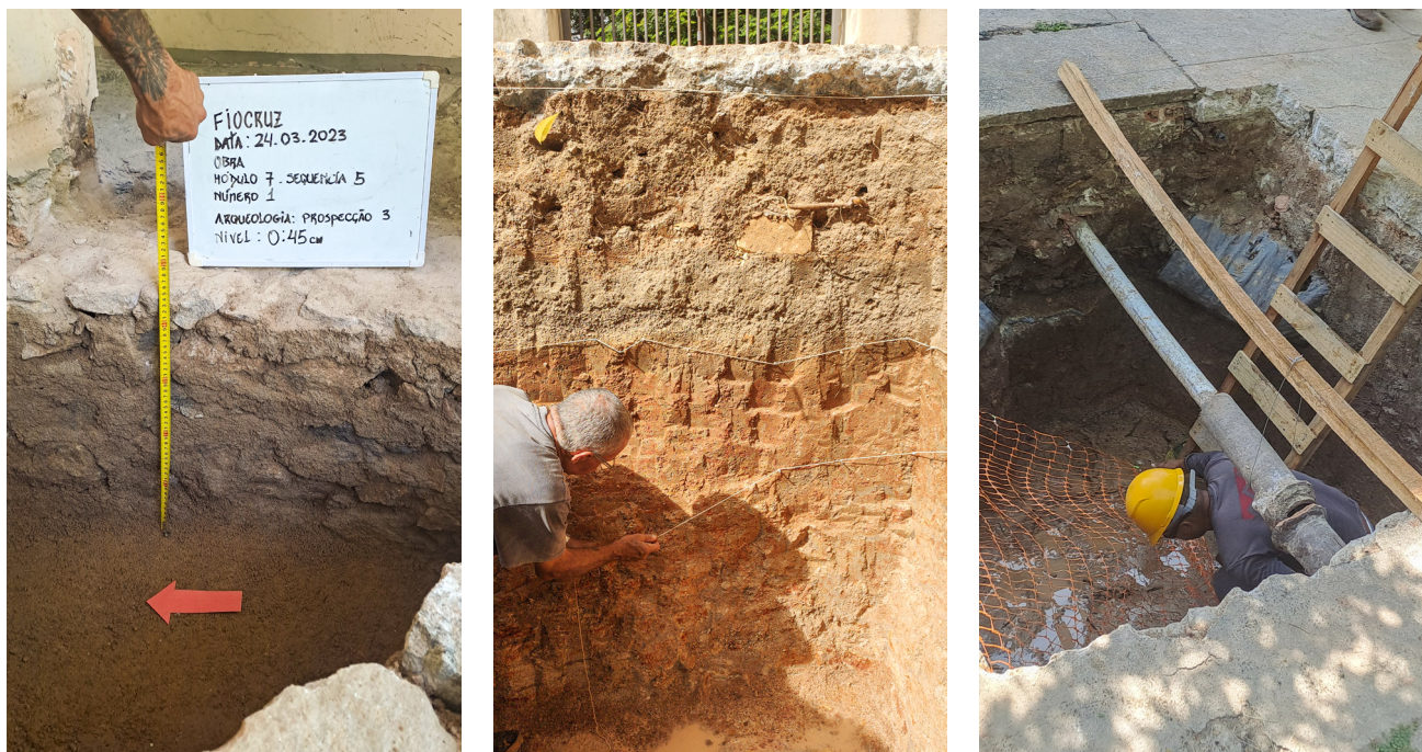
Detalhe do trabalho de medida do perfil nos módulos da área de risco
