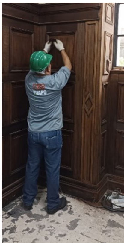
Foram executados serviços de decapagem do teto, remoção de verniz e lixamento de paredes
