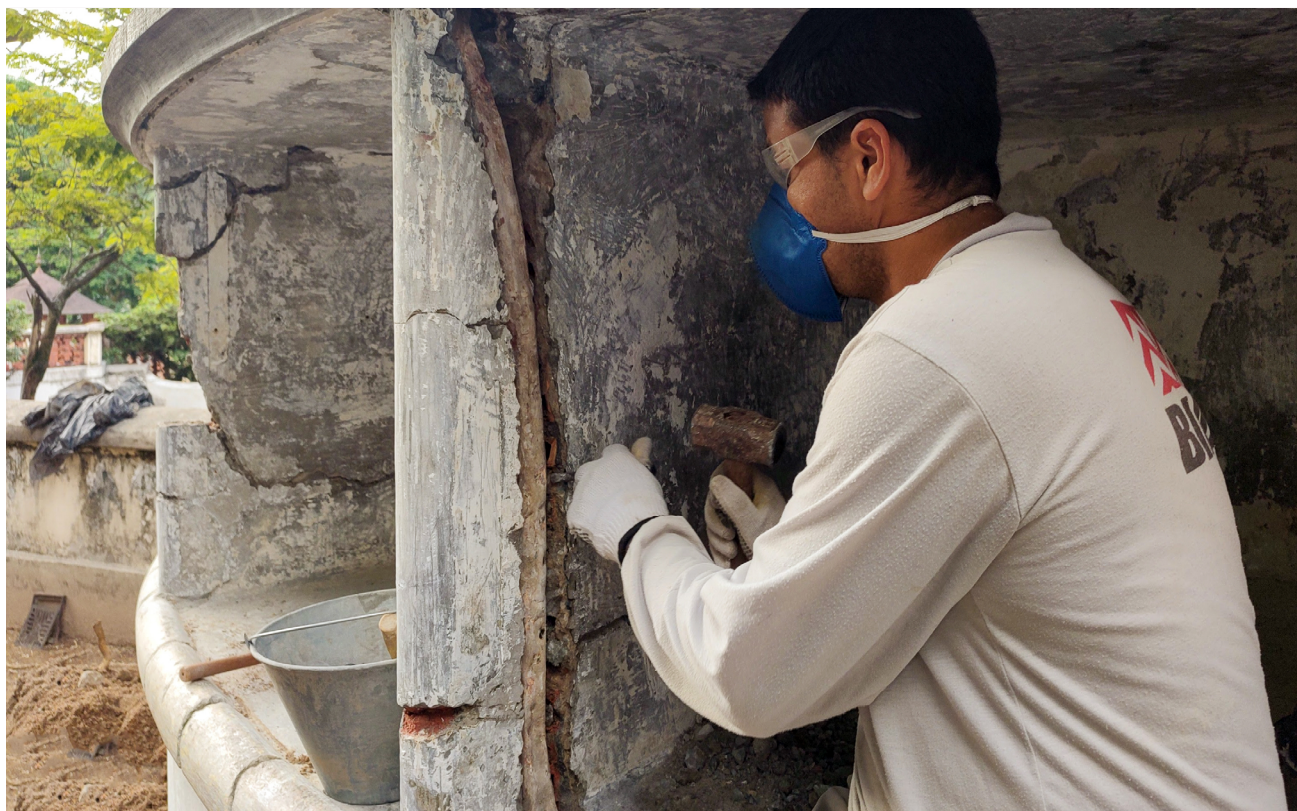
Módulo 3 do Pombal em processo de restauro
