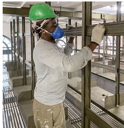
Prateleiras da estanteria passaram por processos de desmontagem, catalogação, lixamento e testes de acabamento
