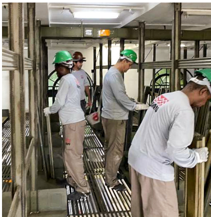
Prateleiras da estanteria passaram por processos de desmontagem, catalogação, lixamento e testes de acabamento
