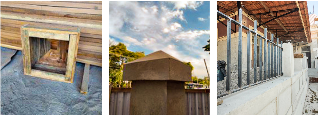
Formas de madeiras foram produzidas para finalização do muro da fachada principal
