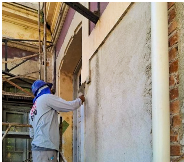
Elementos de destaque na composição arquitetônica recebem aplicação de argamassa
