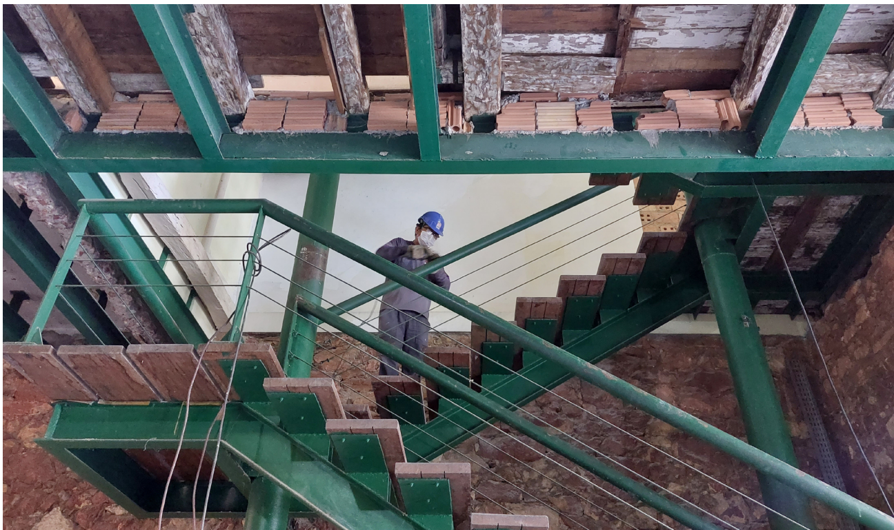
Lixamento do guarda corpo.
