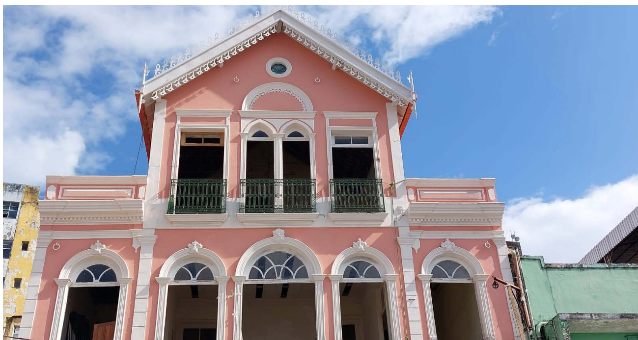
Execução da massa para o recebimento dos rufos.
