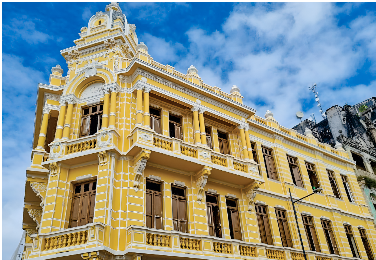
Edificação se encontra na fase de finalização do telhado, das esquadrias e da fachada
