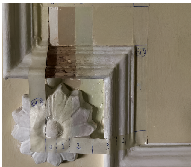
Teste de prospecção de pintura e limpeza do piso de mármore com filete de latão estão em andamento
