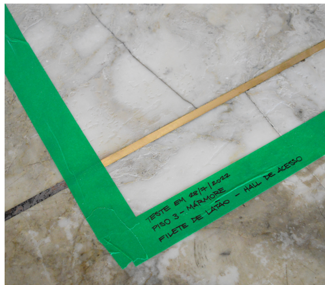
Teste de prospecção de pintura e limpeza do piso de mármore com filete de latão estão em andamento
