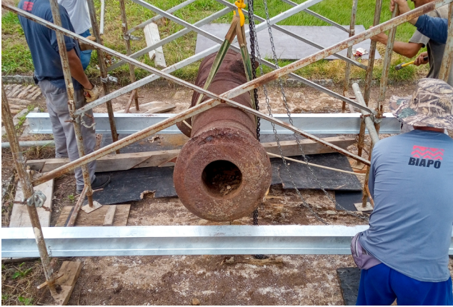
Suspensão do canhão durante a decapagem do piso das canhoneiras e das ruínas da Casa Palamenta
