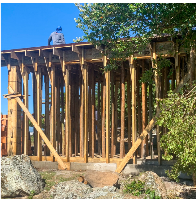
Antes e depois da execução das lajes da casa de baterias do novo sistema de energia
