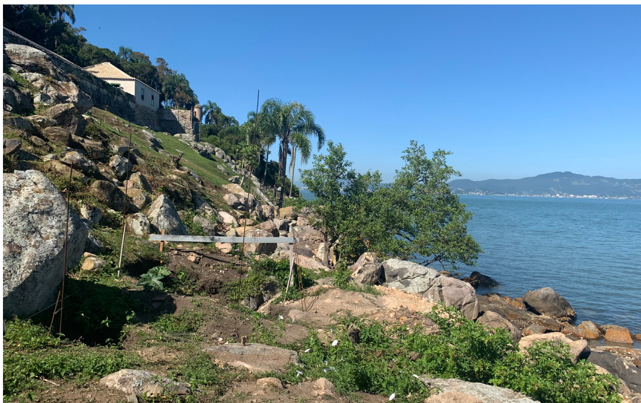
Escavação de solo e perfuração de rochas para fundação do novo deck
