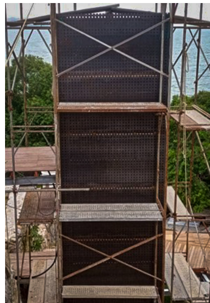
Execução de regularização da passagem e fechamento da torre do elevador foram concluídos
