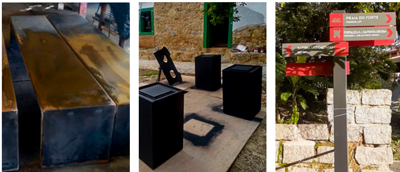
Concluídas as etapas de pintura dos mobiliários para expografia e instalação de placas de sinalização
