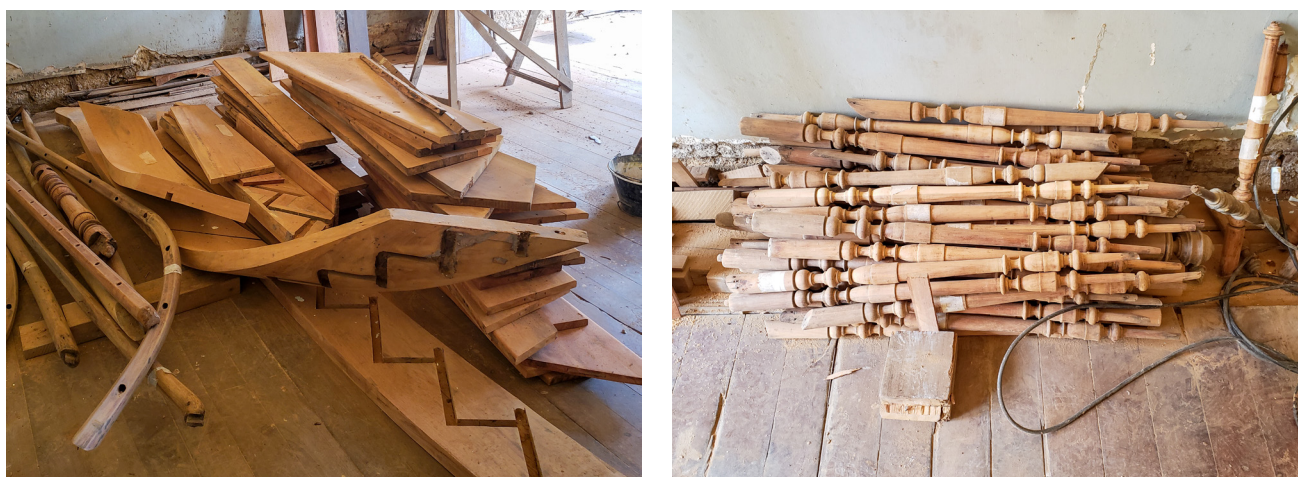
Peças de madeira da escada catalogadas e em processo de restauro para posterior montagem
