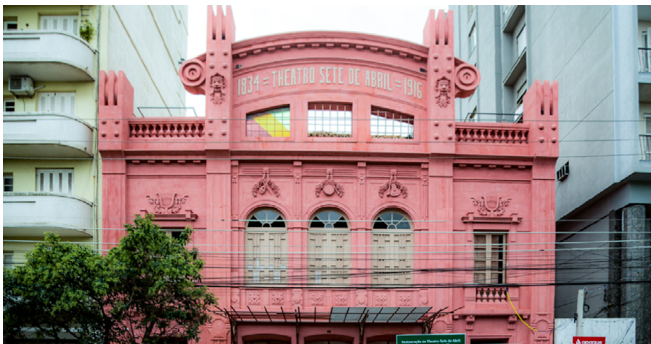
Obras de restauro no prédio histórico iniciaram em setembro de 2019
