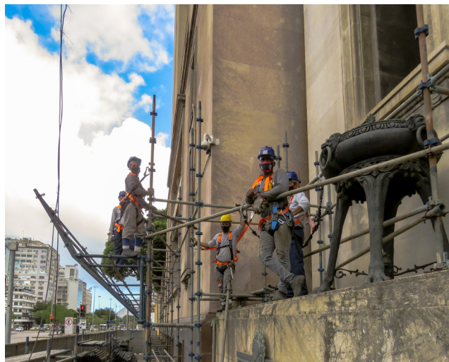
Plataforma de andaimes fachadeiros permite a circulação da equipe e de materiais em toda extensão da edificação
