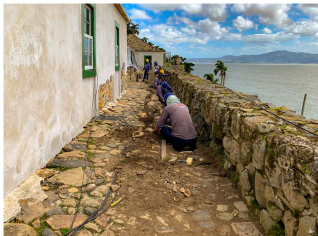
Processo de escavação manual realizado no momento da passagem da tubulação elétrica
