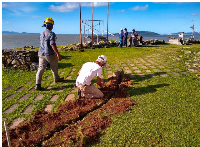
Processo de escavação manual realizado no momento da passagem da tubulação elétrica
