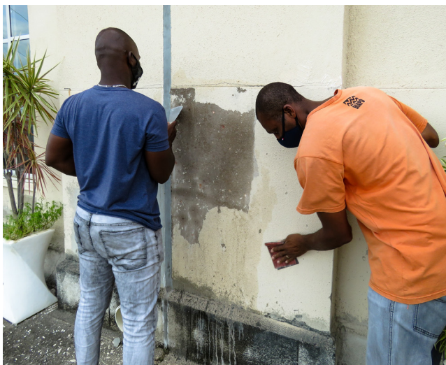
Testes manuais e de prospecção contribuíram para avaliar a melhor técnica de remoção e verificar camadas de pinturas subjacentes, respectivamente
