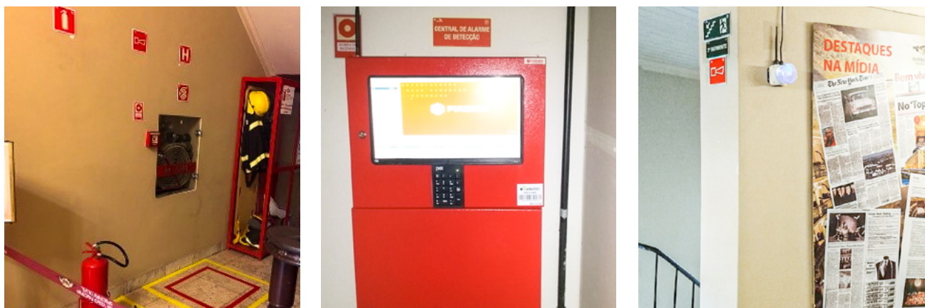
Instalação de alarmes contra incêndio e sinalização de hidrantes com placas fotoluminescentes são acompanhadas por técnicos de segurança do trabalho
