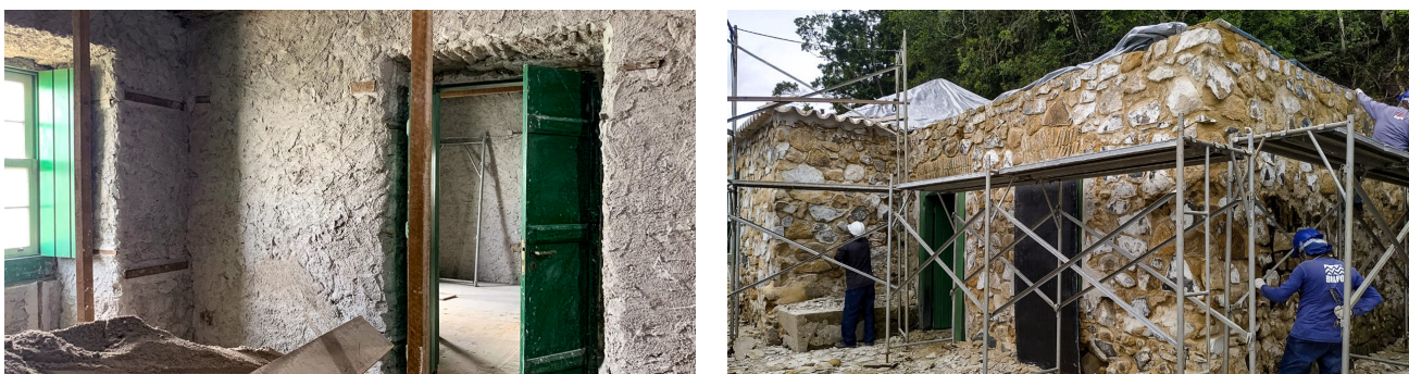
A Casa do Comandante e os demais edifícios e muralhas do forte foram construídos com granito extraído da própria ilha
