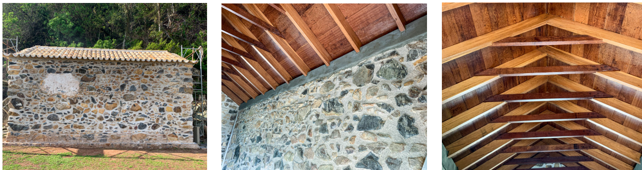
Edifício com função de armazenar instrumentos de artilharia é o único que ainda permanece íntegro nas fortificações restauradas em Santa Catarina
