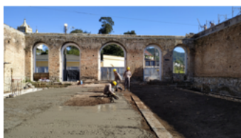
Ruínas do Armazém Macedo recebem trabalhos de fundação e aterramento
