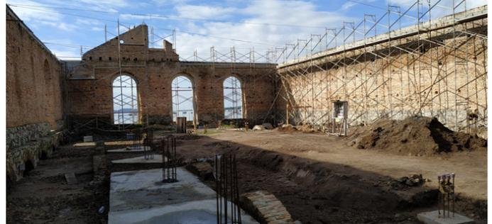
Fundação e instalação de vigas executadas na obra do Armazém
